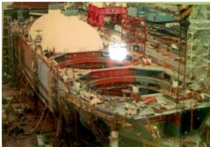
Pintura com “Holding Primer”
