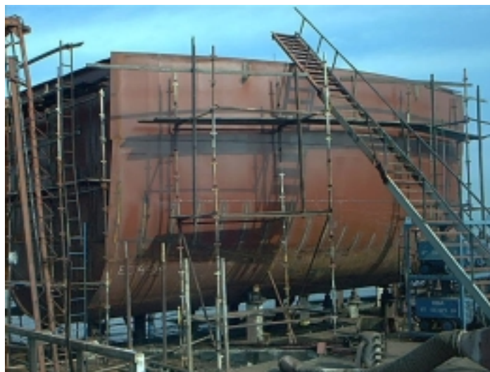
Parte de um casco pintado com “primer”
